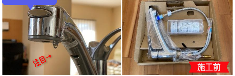
施工事例その②
